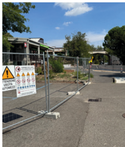
Il cantiere attuale nella stazione della metropolitana di Cascina Burrone, dove si sta realizzando il progetto di ATM per abbattere le barriere architettoniche
