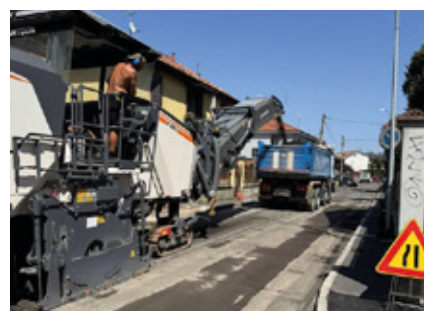
Una fase della riqualificazione stradale in via Pisacane
