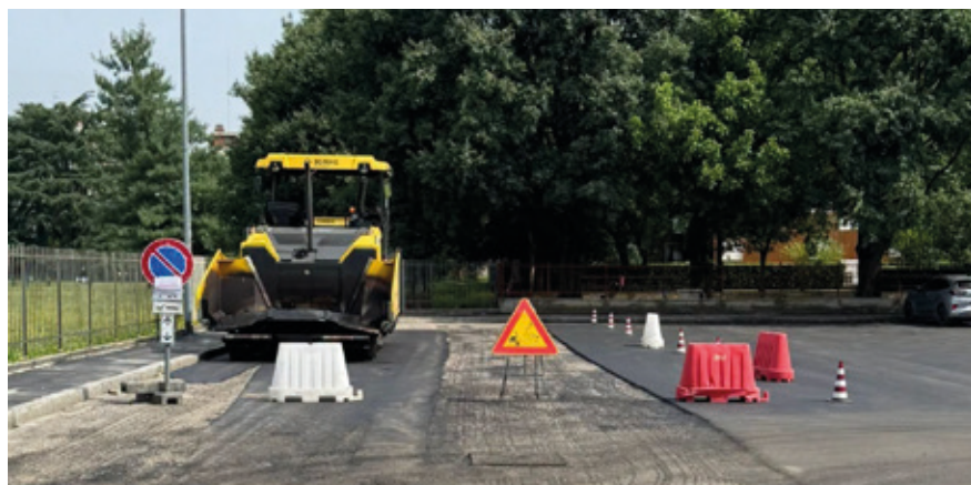
Lavori di manutenzione stradale e di rifacimento dei marciapiedi nel parcheggio adiacente a via Marconi
