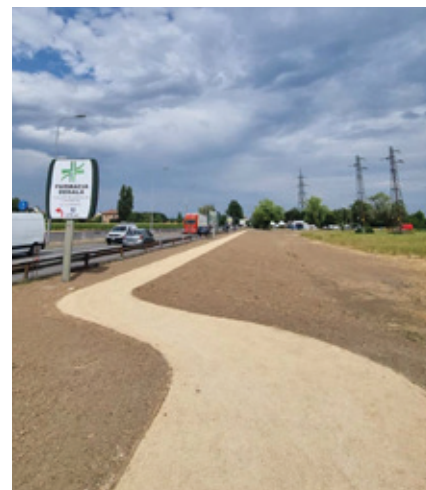
La prima fase dei lavori della Green Way con la realizzazione di un passaggio pedonale protetto
