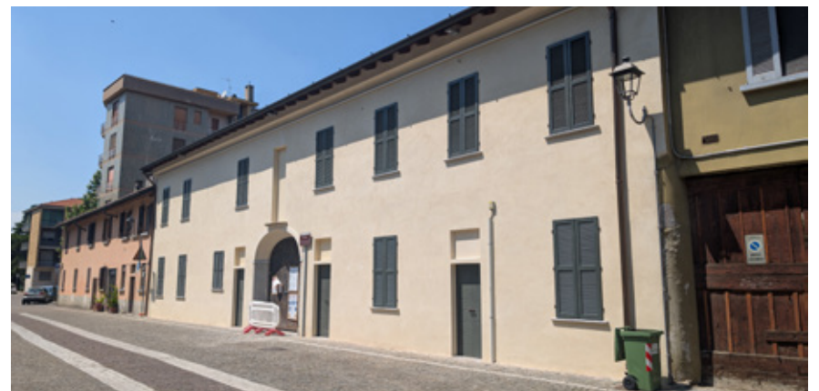
La facciata di Villa Torri su via Sant'Ambrogio
