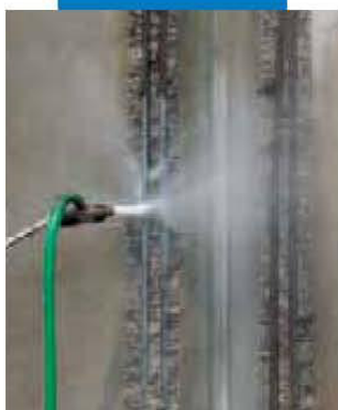
Pulizia dei ferri con idrosabbatura
