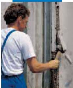
Demolizione del calcestruzzo degradato
