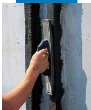
Rifinitura con frattazzino
