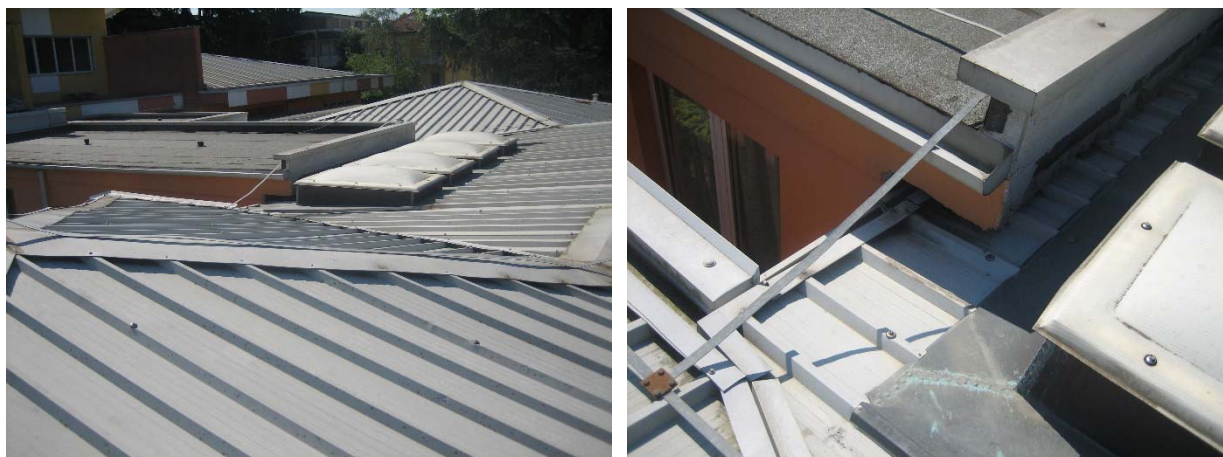
Figura 2- Raccordo tra la copertura piana del corridoio e quella inclinata dell'atrio (PUNTO 1)
