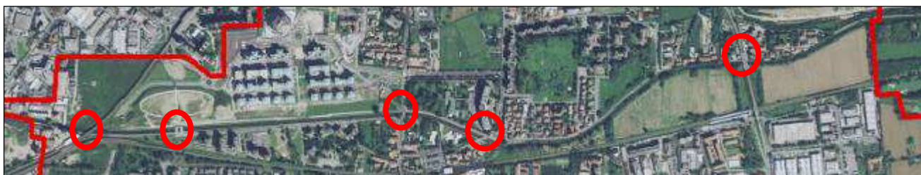
Figura 22 – Infrastrutture sopraelevate di attraversamento del Naviglio Martesana
