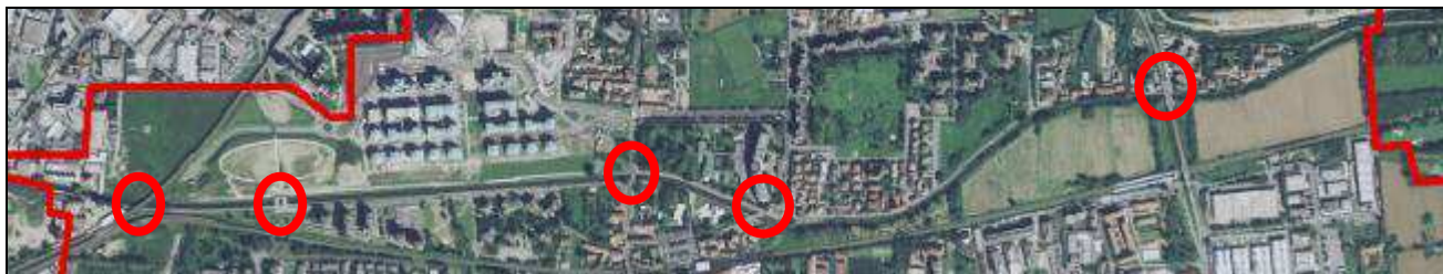
Figura 54 – Infrastrutture sopraelevate di attraversamento del Naviglio Martesana
