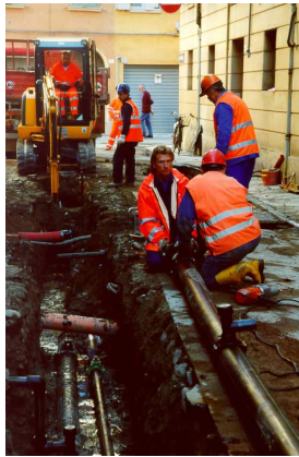
Intervento di manutenzione straordinaria sui sottoservizi
