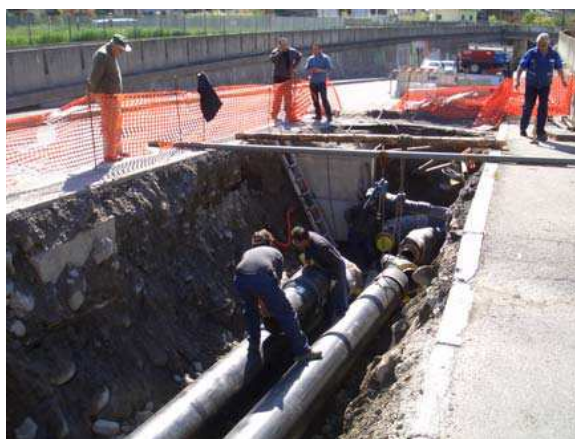
OPERAZIONI DI POSA DI TUBAZIONI PER IL TELERISCALDAMENTO
