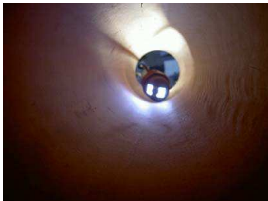
INGRESSO DI UNA TELECAMERA IN UNA TUBAZIONE
